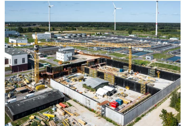
Zum Ausbau des Klärwerks Schönerlinde gehören fast ein Dutzend Einzelprojekte, die insgesamt Investitionen von gut 180 Millionen Euro ergeben.
