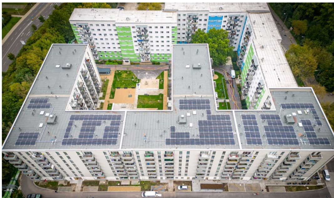
Die Berliner Stadtwerke haben gemeinsam mit der Berliner Wohnungsbaugesellschaft Gewobag ein neues Mieterstrom-Projekt verwirklicht. 317 Haushalte in Lichtenberg können damit künftig vom günstigeren Ökostrom vom eigenen Dach profitieren.
