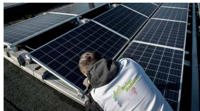
Installation einer Solaranlage auf dem Dach der Max-Taut-Schule in Berlin-Rummelsburg
