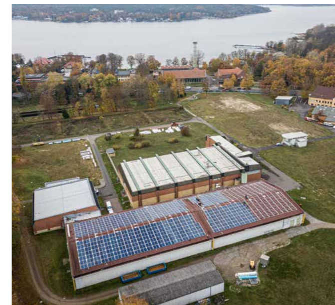
Bau der Photovoltaikanlage auf dem Dach des Wasserwerks Beelitzhof
